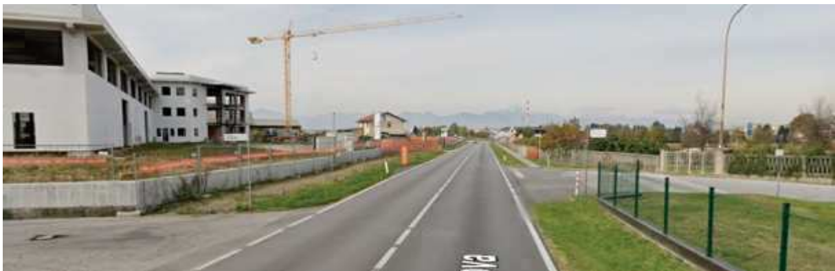
Foto dell'area di intervento
