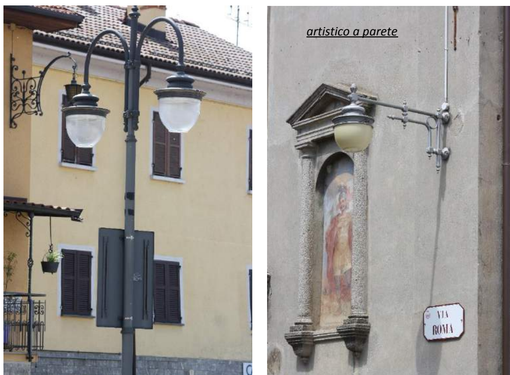
Figura 16 – Vista tipologie sostegni
