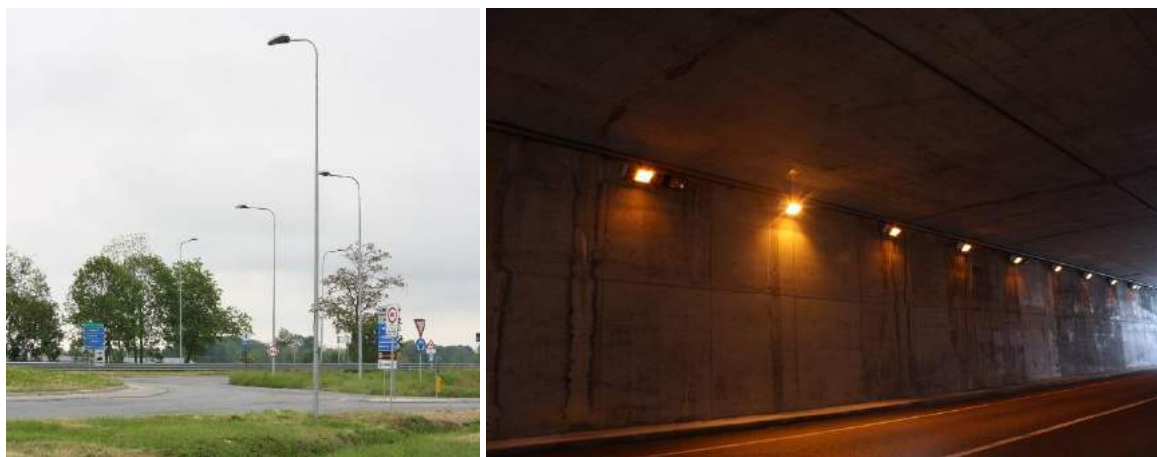
Figura 14 – Vista rotatoria e sottopassaggio Variante di Beinette
