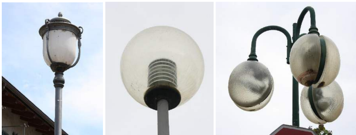
Figura 21 – Armature a sfera installate su punti luce del centro urbano
