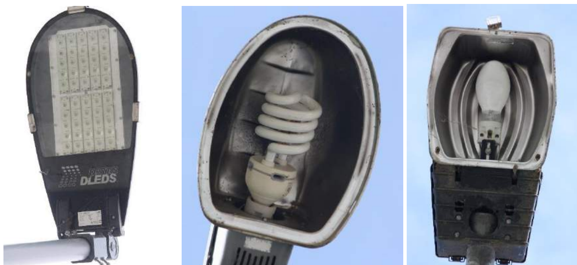
Figura 24 – Immagini lampada LED, fluorescente compatta (Philips 65W), ai vapori di sodio (100W)
